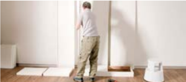
Ustawić bok mebla na cokole. Dzięki wystającej śrubie element jest od razu prawidłowo ustawiony.
