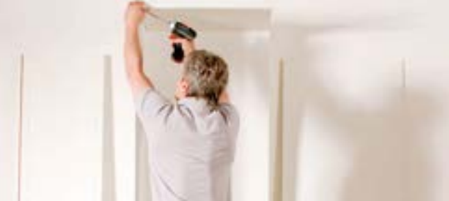
Przygotować wkrętkę akumulatorową i przykręcić przedni narożnik. W ten sposób możliwy jest bezproblemowy montaż również przez jedną osobę.
